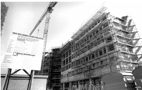
Rohbau des GEP-Gebäudes 1992
